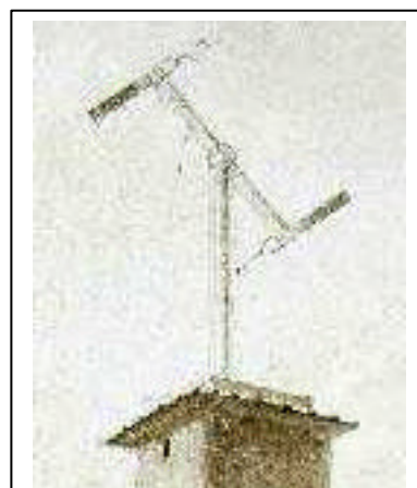
Figure 23 : Les bras articulés de la station du Trou d'Enfer
